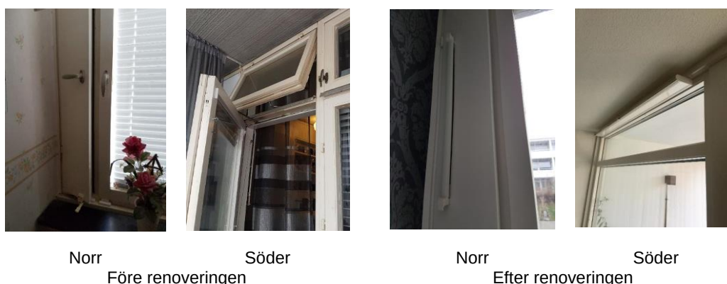
Figur 3. Vädringsluckor, vädringsfönster och ventiler före och efter renoveringen.
